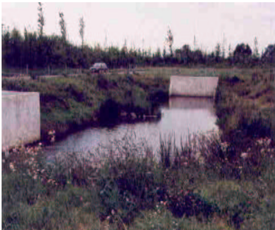
Regenrückhaltebecken an der B 93 bei Mosel
