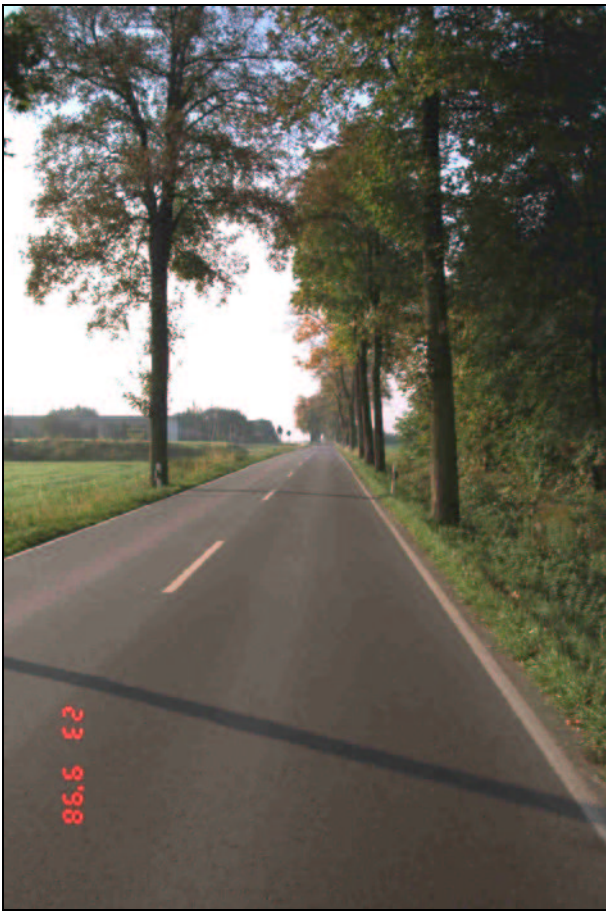
Bild 2: Streckenabschnitt ohne Schäden (S 201; Oederan - Kreuzung S 203) [4]
